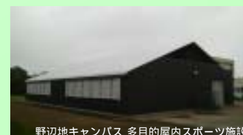
野辺地キャンパス 多目的屋内スポーツ施設
