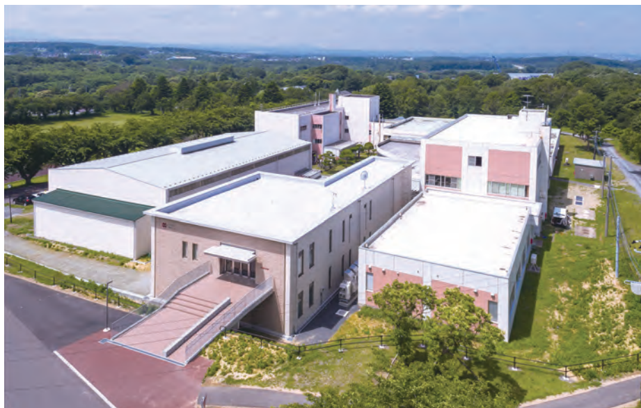
八戸学院大学短期大学部幼児保育学科棟(中央の校舎。平成27年12月竣工)
