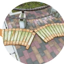
電動サンダーで表面を削り、パテでひび割れを補修した後、ビスを塗ります。
