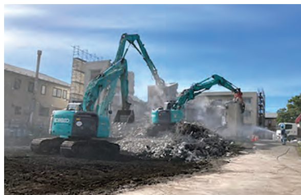
昭和56年に建設された職員住宅取り壊しの様子
