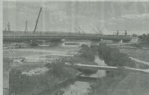
馬淵川の新大橋は架け替え工事中です＝6日
