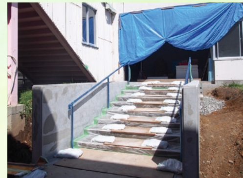
ピアノレッスン室入口前の階段工事
