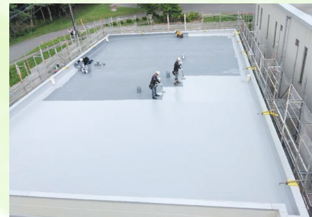
2号館屋上の塗装工事の様子
