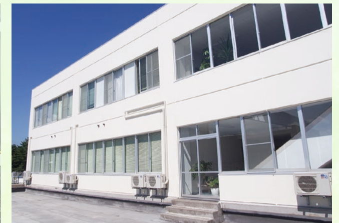
2号館の外壁塗装工事が完了
